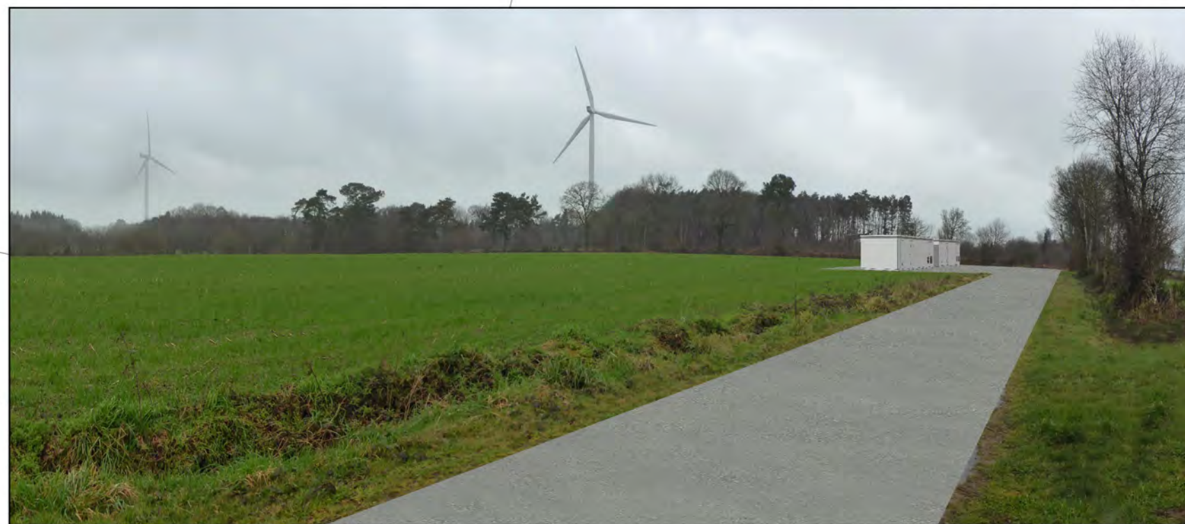
Après l'implantation des postes de livraison
