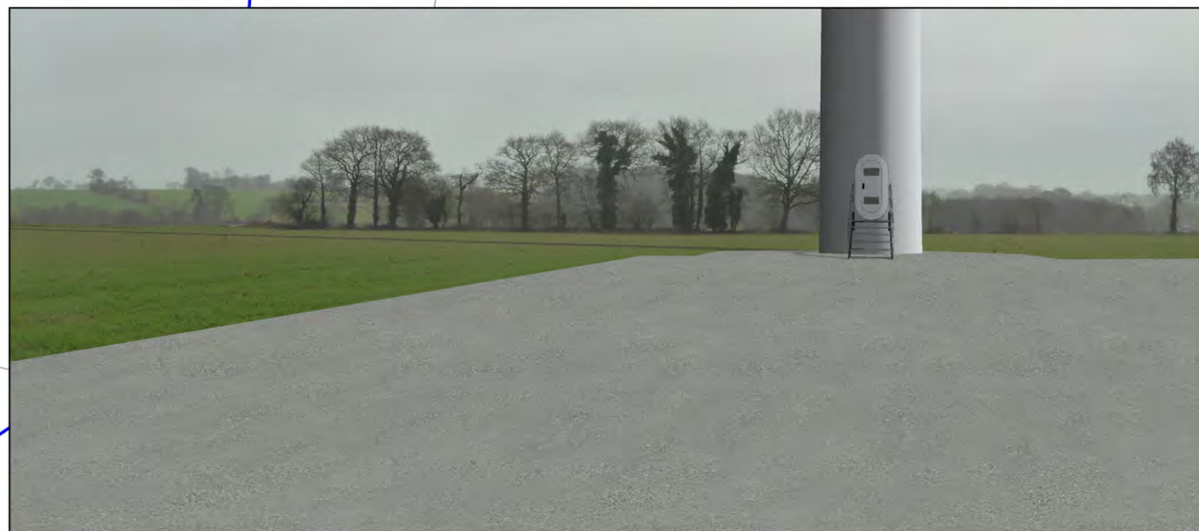
Après l'implantation de l'éolienne
